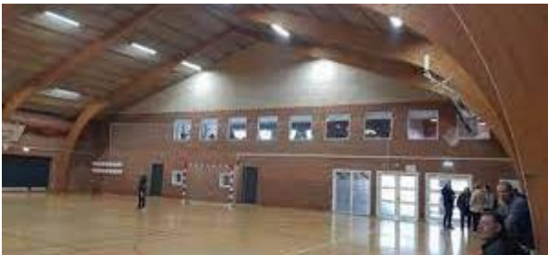
Båndby-Hallen i Storvorde
